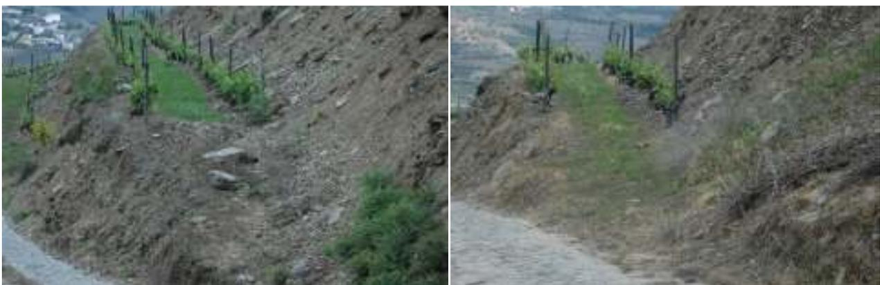
FIGURA 24 – Exemplos de ligações, incorrectas e correctas, entre os patamares e estradas de circulação
