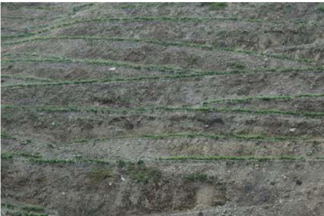
FIGURA 18 – Forma incorrecta de implantação de patamares, em que não existe paralelismo entre si ocasionando múltiplas alturas dos taludes, problemas graves de erosão e baixa rentabilidade do trabalho
