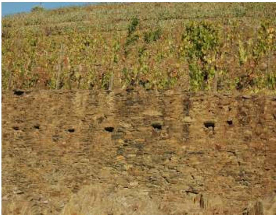
FIGURA 3 – Geios pré-filoxéricos com drenos nos muros designados por “*pilheiros*”
