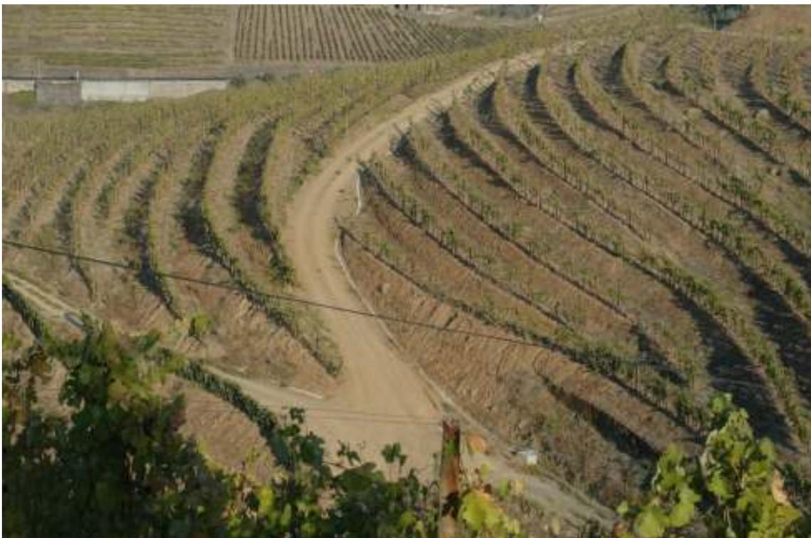
FIGURA 26 – Patamares de 1 bardo. A drenagem das águas é assegurada quer pela inclinação longitudinal dos patamares quer através das manilhas e colectores nas estradas de acesso
