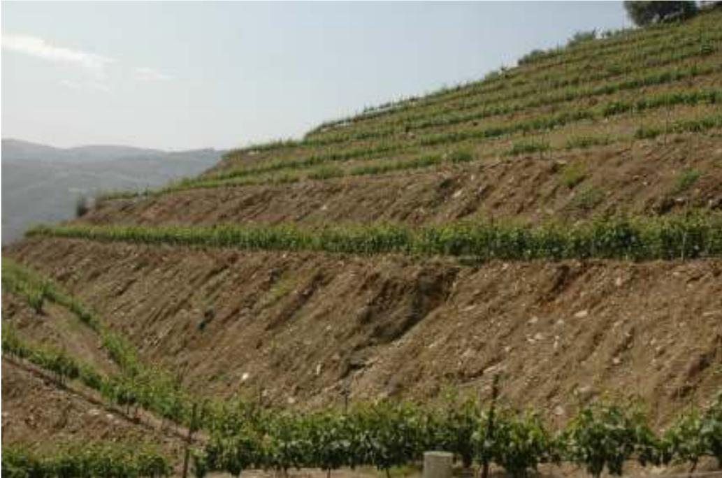
FIGURA 17 – Exemplo de ravinamento em taludes de alta dimensão com deficiente sistema de controlo contra erosão
