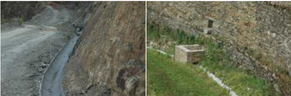
FIGURA 20 – Drenagem com meias manilhas nas estradas de acesso aos patamares, cuja inclinação longitudinal permite que as águas escorram para a rede de drenagem da parcela, evitando assim a ocorrência de ravinamentos nos taludes e pormenor de colector de águas para descarga em meias manilhas dos patamares
